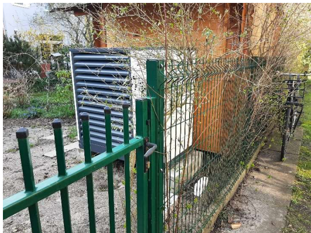
Luft-Wasser-Wärmepumpe in der Wiesenerstraße; Wärmeleistung 10 kW; Inbetriebnahme April 2023
