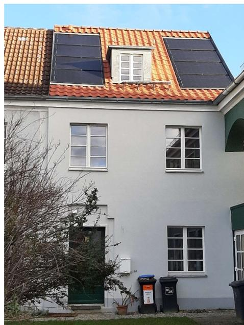
Paradestr. 59: Sanierung 2021; 12 cm; Resol-Hartschaumplatten; neue Fenster nach außen versetzt
