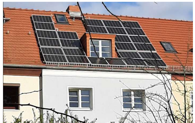
Beispiel für maximale Flächenausnutzung: 13 Module je 360Wp ergeben 4,68 kWp
