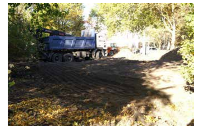
Parkplatz Bäumlerplan: Renaturierung mit 30cm Bodenaustausch
