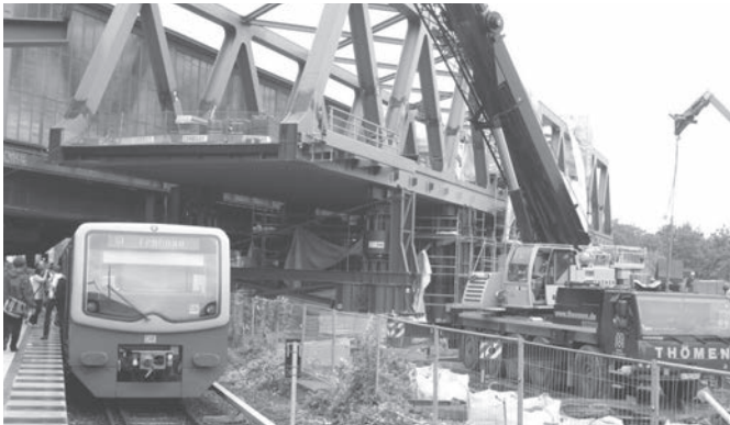
Einsetzen der neuen Fachwerkbrücke am Bahnhof Schöneberg
