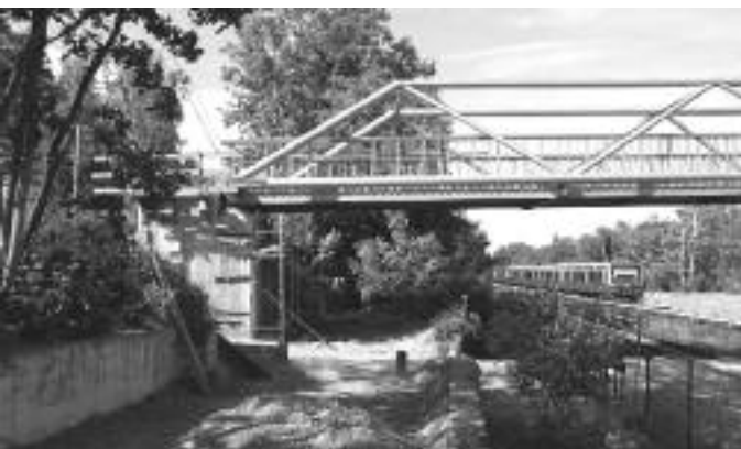
Widerlager West mit S-Bahn
