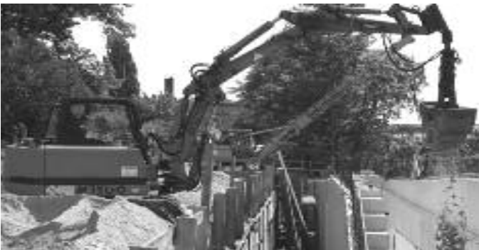
Herstellung Rampe und Treppe an der General-Pape-Straße
