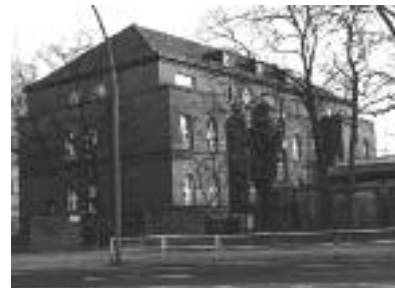
ehemaliges Offizierscasino, heute Havelland-Grundschule
