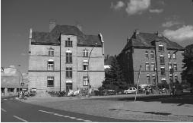
Kaserne an der General- Pape- Straße
