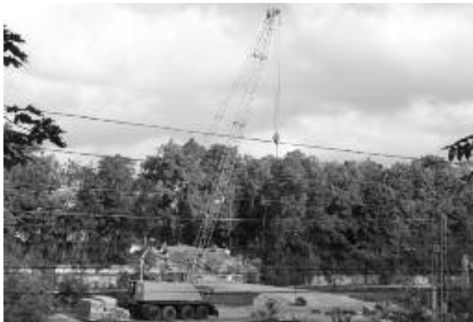
Brückenbaustelle an der General- Pape- Straße
