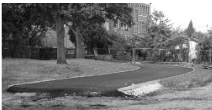
Neue Grünanlage an der Gontermannstraße im Bau
