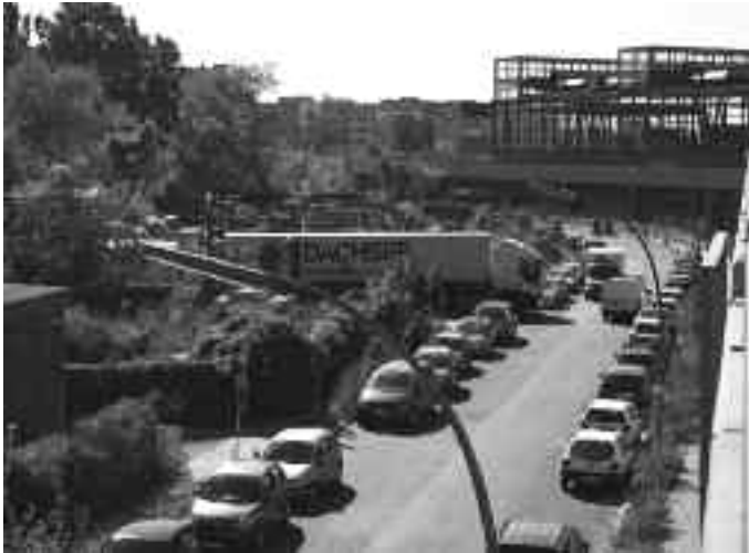
Die Papestraße wird um LKW-Länge nach links verlegt
