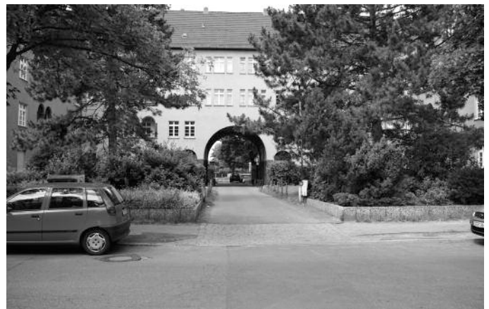
Torweg zum ehem. Kasernengelände
