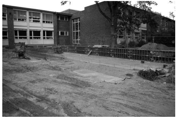
Mensabaustelle am Wolffring hier entsteht ein Holzpavillon
