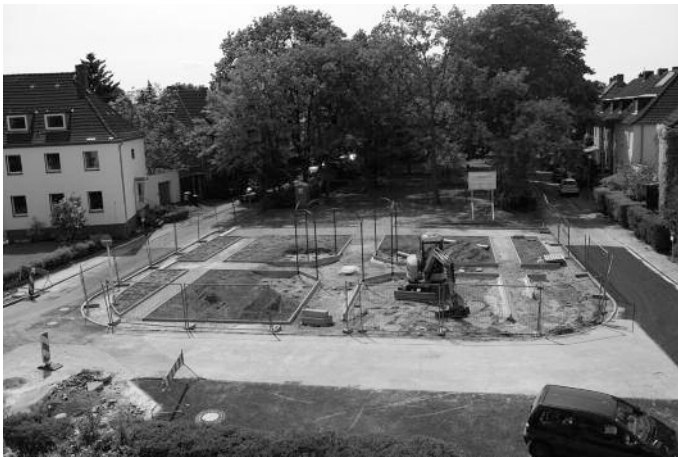
Baustelle Rosengarten im Mai
