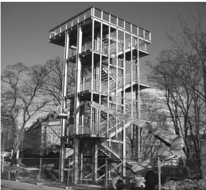
Baustelle Aussichtsturm am Belastungskörper
