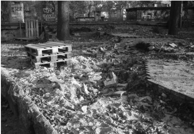
Abb.11 : Baustelle Fliegerspielplatz Bundesring
