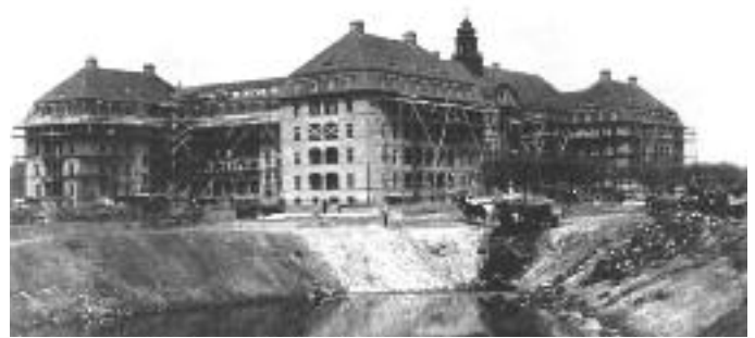
Abb.11 : die Neubauarbeiten liegen in den letzten Zügen Aufnahme vom 15.5.1928
