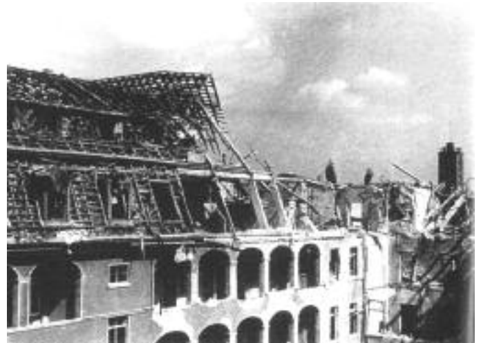
Abb.13 : Schwere Kriegsschäden Zustand 1945, hinten rechts Turm der "roten Schule"
